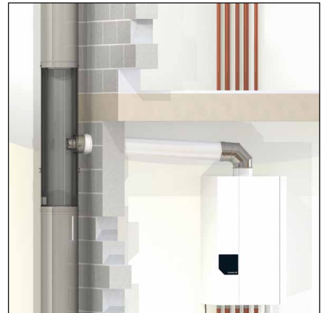
Aansluitelement naar de CV-ketel(s)
